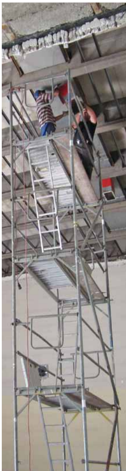
Deckendemontage im Hochspannungslabor
