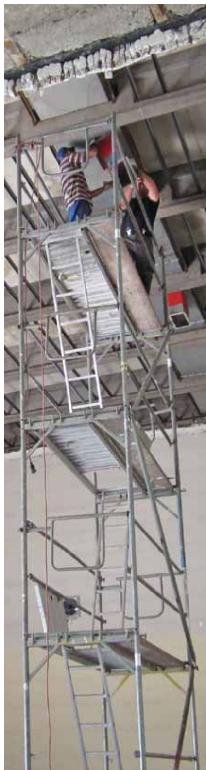
Deckendemontage im Hochspannungslabor
