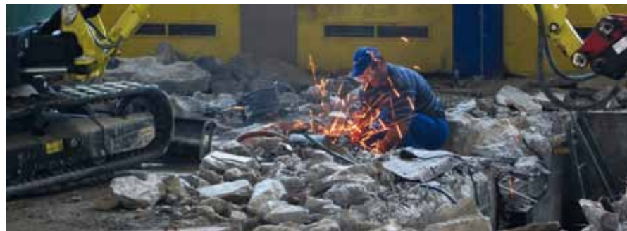
Bei der Entfernung des Betonboden wurde ein alter Bremsenprüfstand »wiedergefunden«
