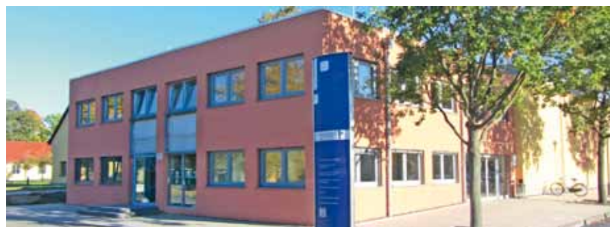
Fertiggestellt wurde das neue Hörsaal-Gebäude in Soest
