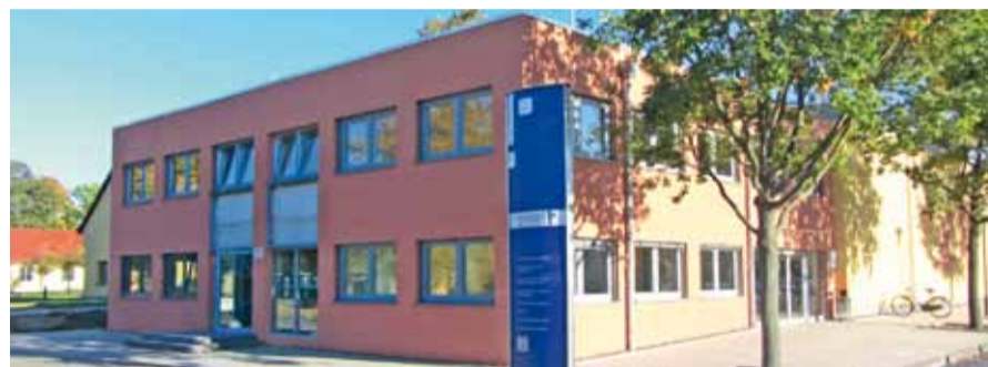
Fertiggestellt wurde das neue Hörsaal-Gebäude in Soest
